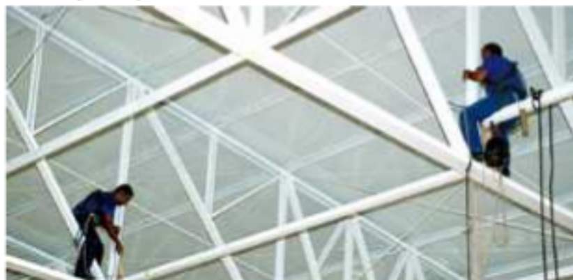
Processo teve início com a troca da cobertura metálica
